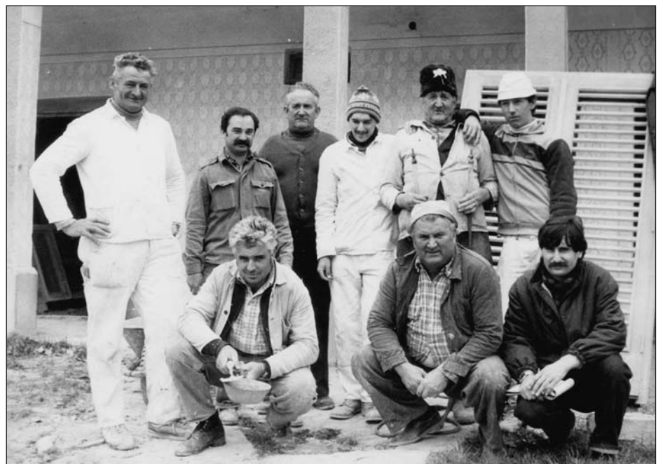
ANDRÉ KERTÉSZ EMLÉKHÁZ ÉPÍTÉSÉN A BRIGÁD
